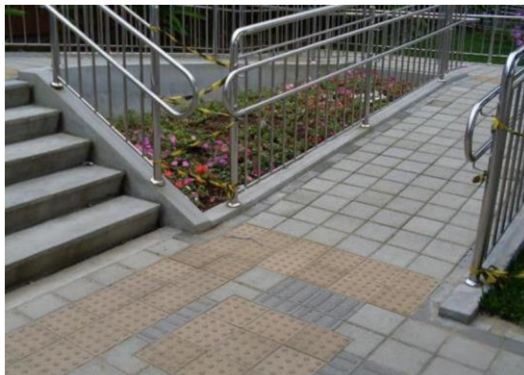
Figura 32 - Instalação de Piso Tátil e Rampa (Proj. Milena Mesquita Galvão, 2010) Fonte: UFSC/DPAE (2016b)
